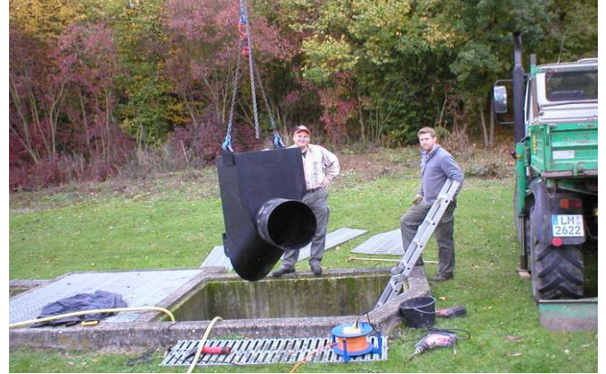
Perma-DiK Montageadapter beim einsetzen
