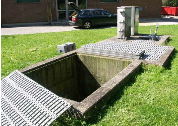
Vorhandener Auslaufschacht
