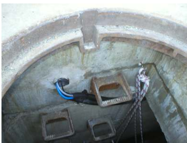
Kabel im extra beweglichen Schutzschlauch. Damit Alligator hochklappbar bleibt.
