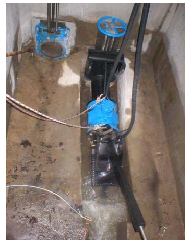
Perma-DRIK Alligator eingebaut.
