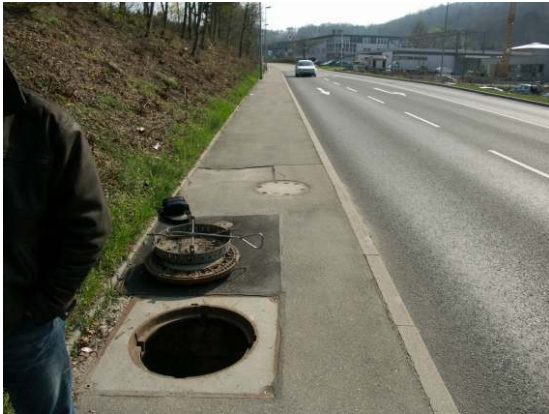
Vorhandener Drosselschacht. Direkt an der "Neuen Ramtelsstr." Baumassnahme unerwünscht.
