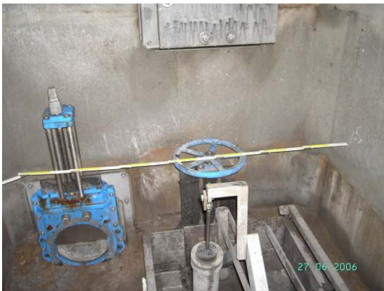
Profilabnahme - Ausmessen der Schachtsituation.
