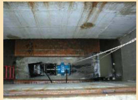
Der Staukasten dient als Notüberlauf.
