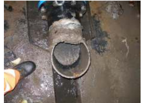
Typische Ablagerung durch Sand. Der Durchfluss- Messfehler ist kleiner 2%
