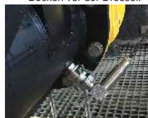
Druck-Höhenstands-sonde misst bei geschlossener Alligatorklappe/Anaconda-Ventil den Höhenstand im Becken vor der Drossel.
