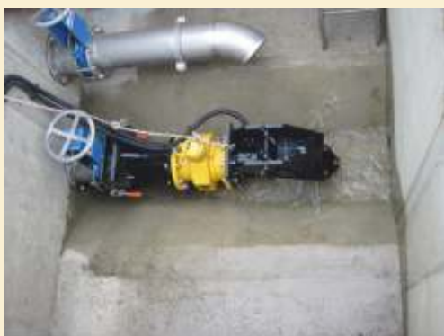
Alligator DN 200 aus PE (mit Notablass)
