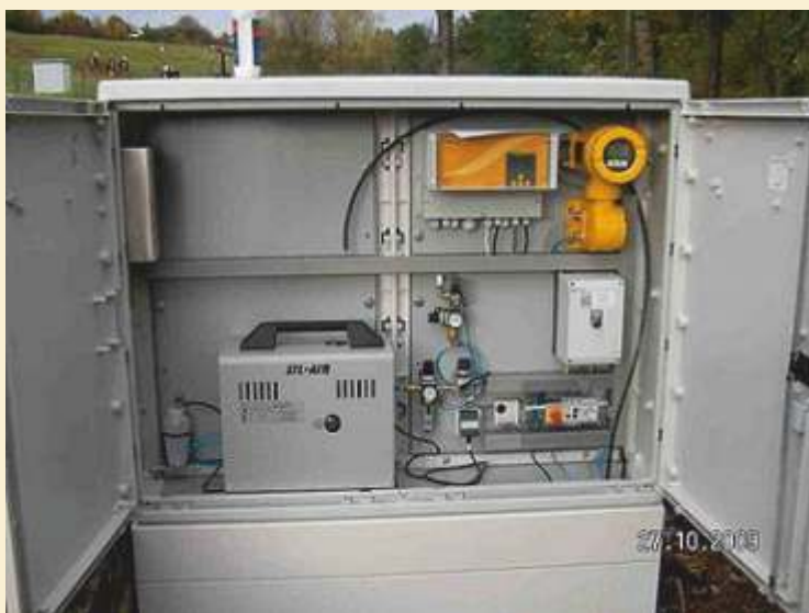
Freifeldschrank für Alligator DN 150 bis DN 300 mit Platz für Kompressor
