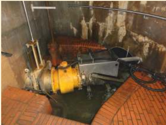
Alligator DN 500 (VA) gekrümmte Einlaufstrecke
