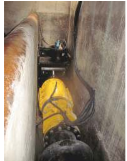
Anaconda als Auslaufversion. Zufluss von links mit Wulst zur Verzopfungreduzierung
